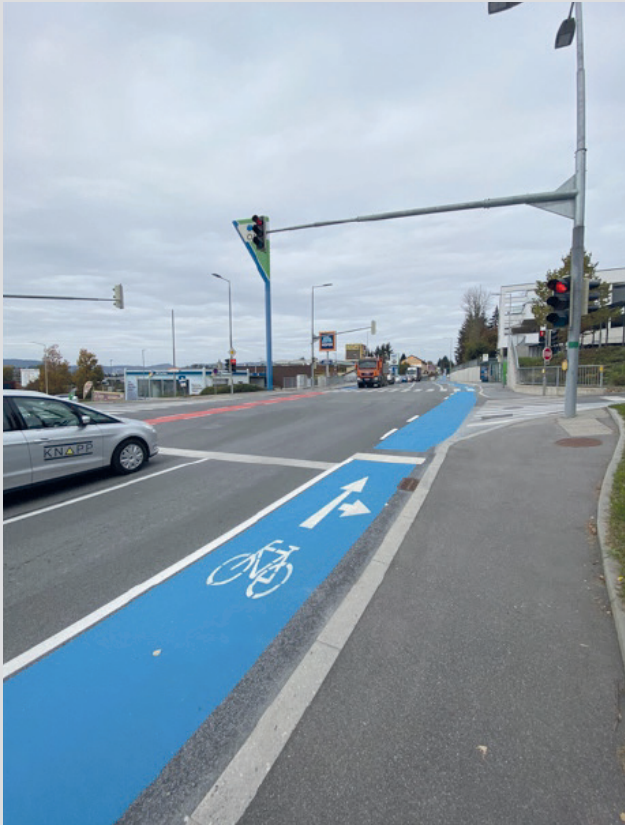
Bild 1: Radfahrstreifen entlang der St.-Peter-Hauptstraße (© sicher unterwegs)
